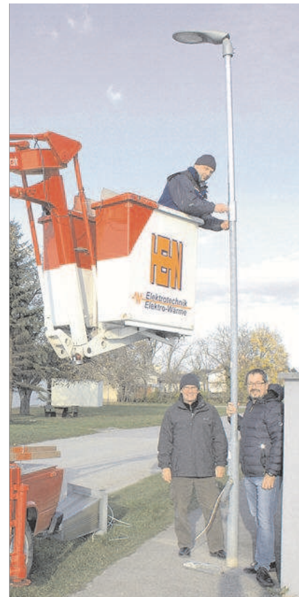
Bürgermeister Ernst Schüller und Amtsleiter Hannes Laschober überzeugen sich von der sachgerechten Installation.
